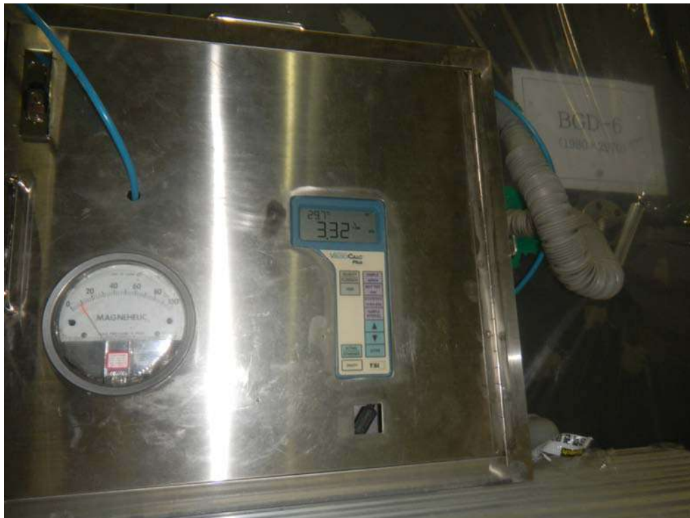
<photo> air leakage test<BGD - 6>
