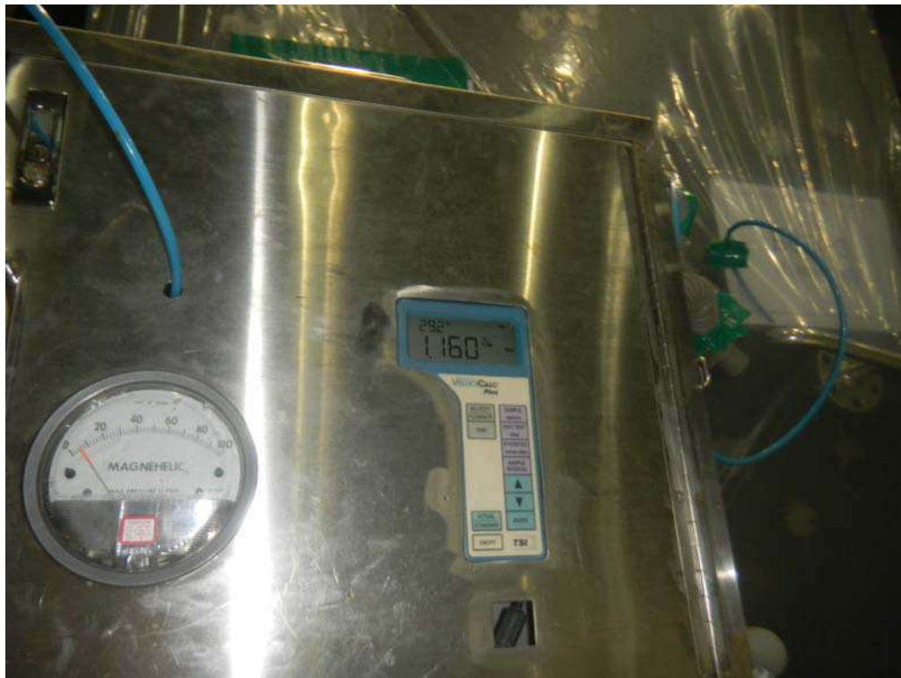
<photo> air leakage test<BGD - 3>
