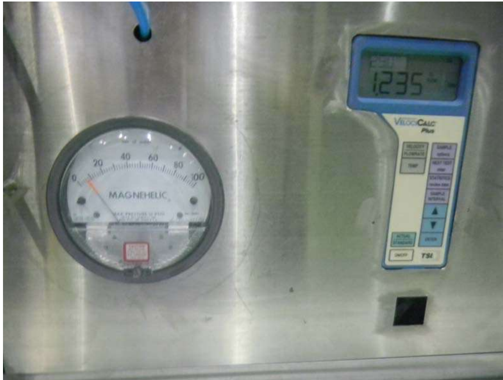
<사진> air leakage test<BGD - 1>
