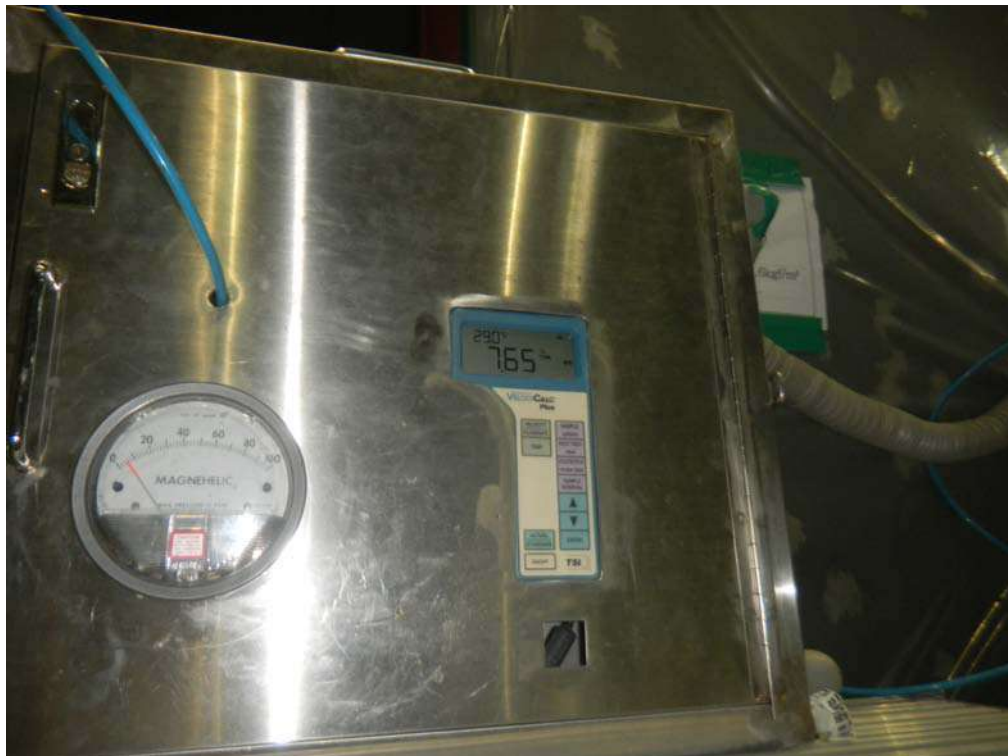
<Photo> air leakage test<BGD - 4>
