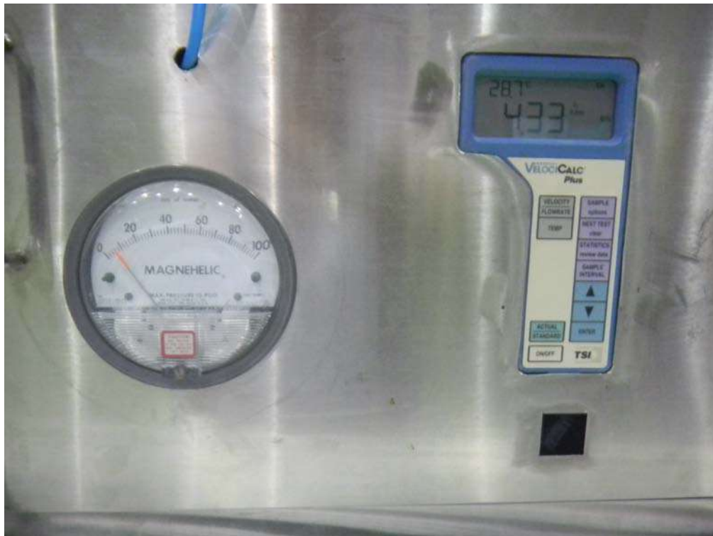
<사진> air leakage test<BGD - 5>
